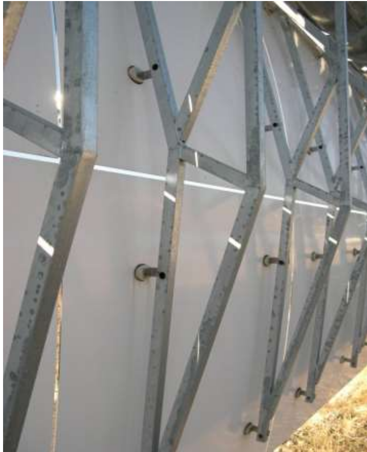
Geschweißte Arme: robust / teuer
